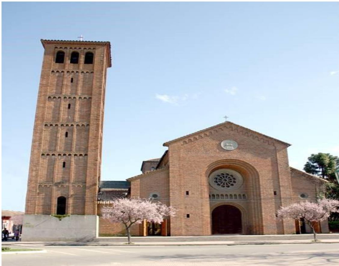
Catedral de San Ambrosio construida frente a la Plaza principal de Linares en 1936
